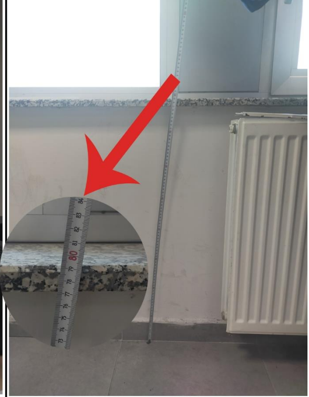
c- PARAPET YÜKSEKLİĞİ 80 CM
