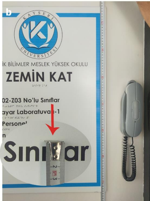
b-DUVARA MONTE BİLGİ LEVHASI ALT 105 CM ÜST 175 CM DİR
