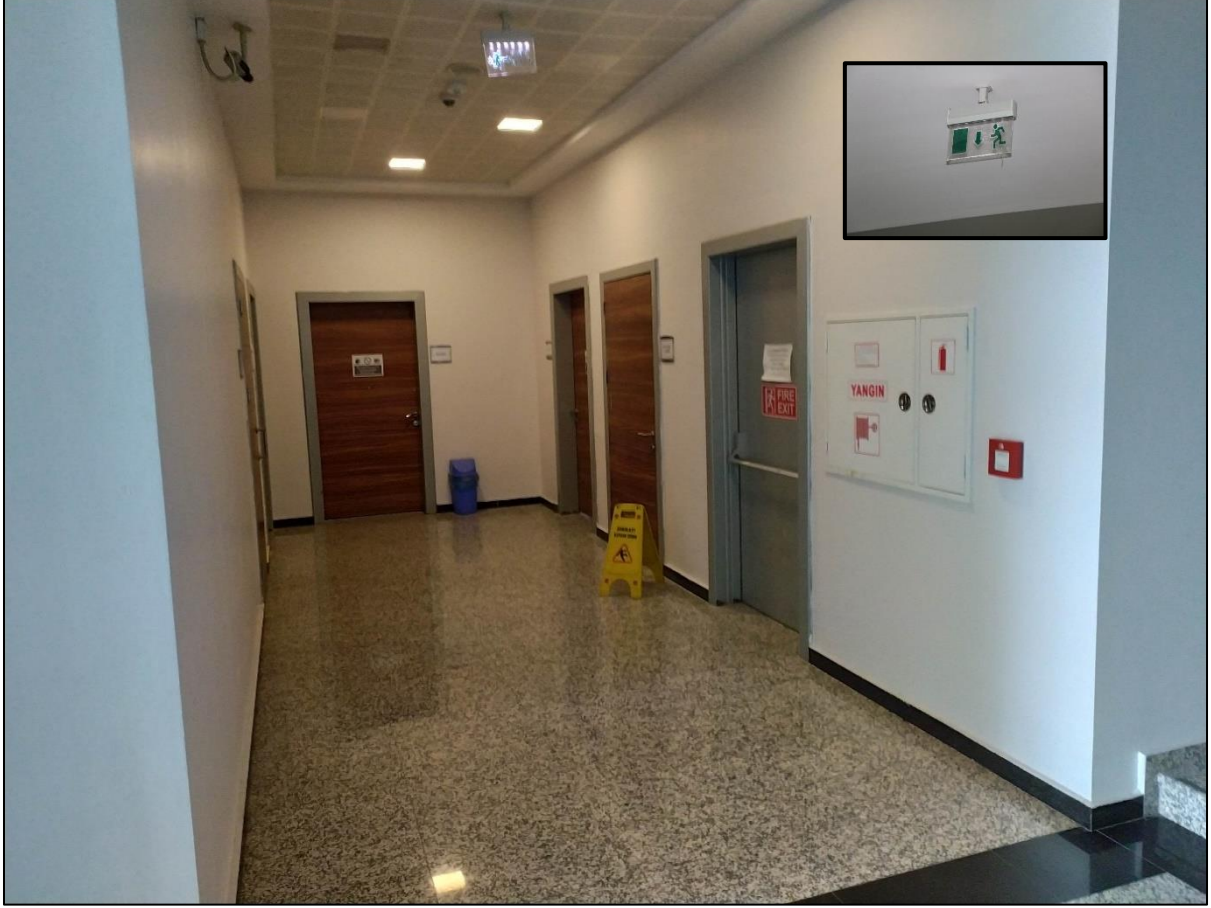
Fotoğraf 7.6. Acil Çıkış Kapısı, Sesli ve Görsel Uyarı cihazları
