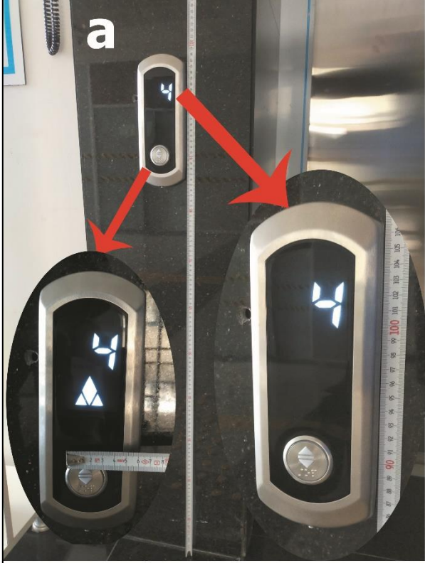
a-Asansör Çağırma Düğmesi Yerden 90 cm yükseklikte olup 3 cm boyutundadır.
