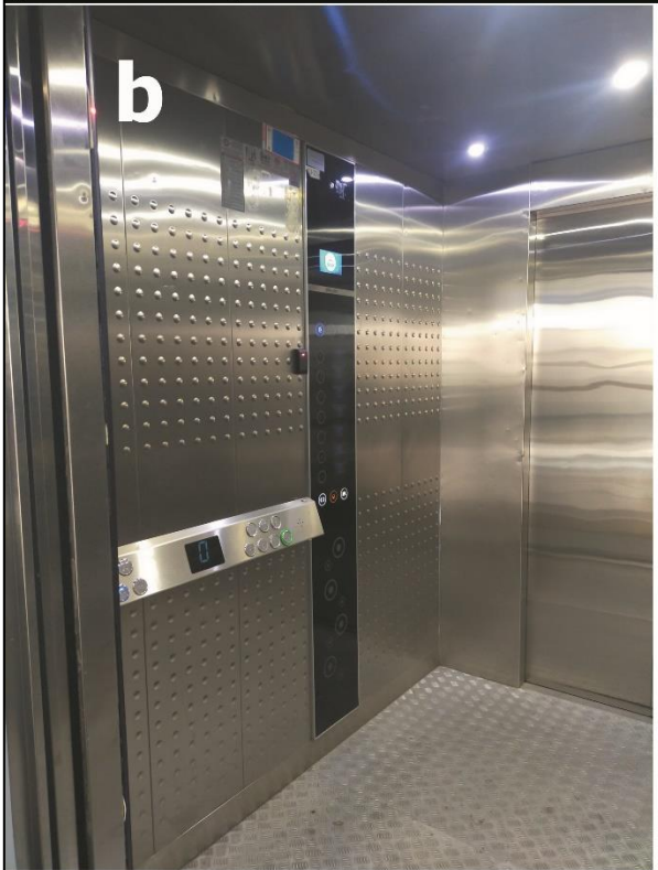
b- Kat işaret düğmeleri boyut bakımından uygundur ve istenen yüksekliktedir
