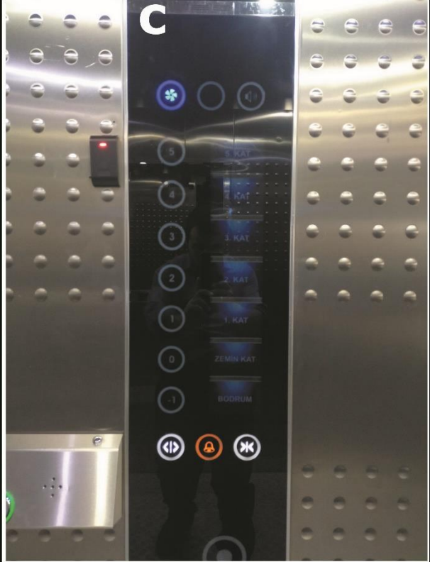
c- Kat işaretleri asansörün hareket yönü ışıklı ve sesli uyarılarla desteklenmiştir.
