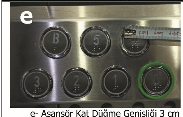
Fotoğraf 4.3. Tüm katlara hizmet veren asansörler, kabin içi ölçüleri, kontrol paneli ve ölçüleri, asansör içinde hareketi zorlaştıracak herhangi bir malzeme bulunmaması
