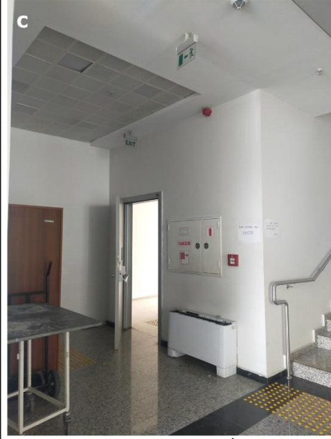
c- TAVANDAN SARKAN İŞARET PANOLARI 300 CM DEN YÜKSEKTİR
