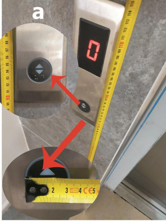
a-Asansör Çağırma Düğmesi Yerden 94 cm yükseklikte olup 3 cm boyutundadır.
