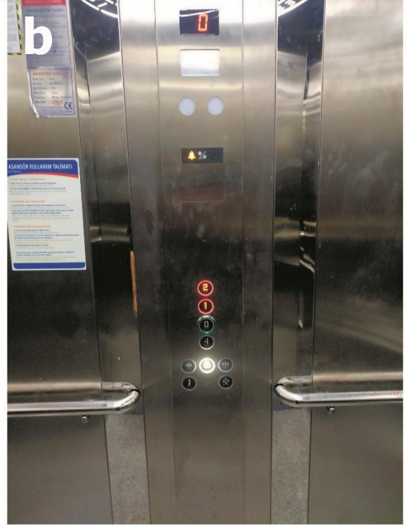
b- Kat işaretleri asansörün hareket yönü ışıklı ve sesli uyarılarla desteklenmiştir.
