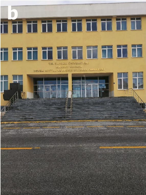
b- Bina giriş merdivenlerinin orta kısmında korkuluk bulunmaktadır.
