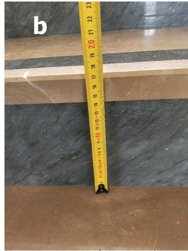
b- Merdiven riht yüksekliği 17,5 cm (Binada Asansör bulunmaktadır)
