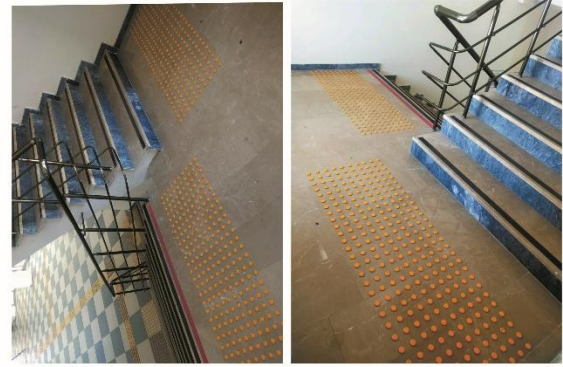
d- Sahanlıkta hissedilebilir yüzey ve basamaklarda zıt renkli kaymaz bant uyg.
