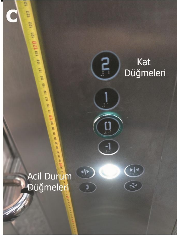
c- Asansör Kontrol Panel Yüksekliği 90-120 cm
