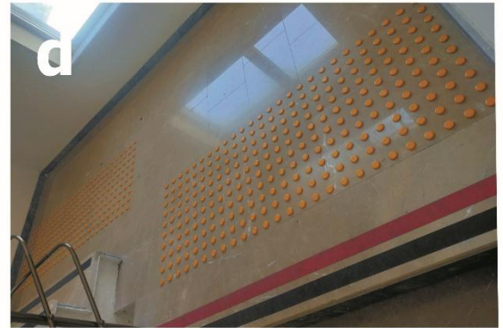
c- 10 basamaklı sahanlık uygulaması ve basamak önü hissedilebilir yüzeyler
