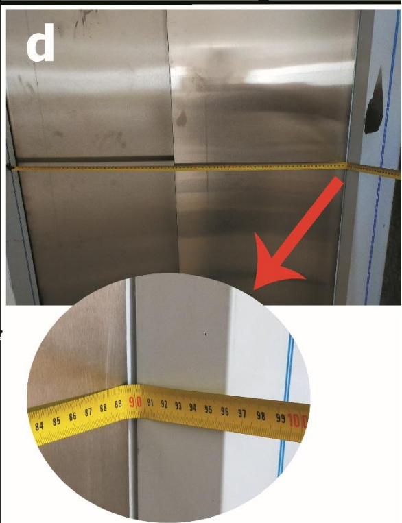
d- Asansör kapı genişliği 90 cm
