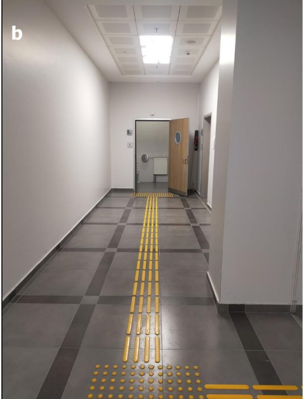
b- Engelli Tuvaletine Hissedilebilir Yüzey İle Ulaşım
