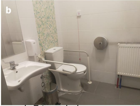
b- Tutunma barları ve Tuvalet Kağıdı Aparatı
