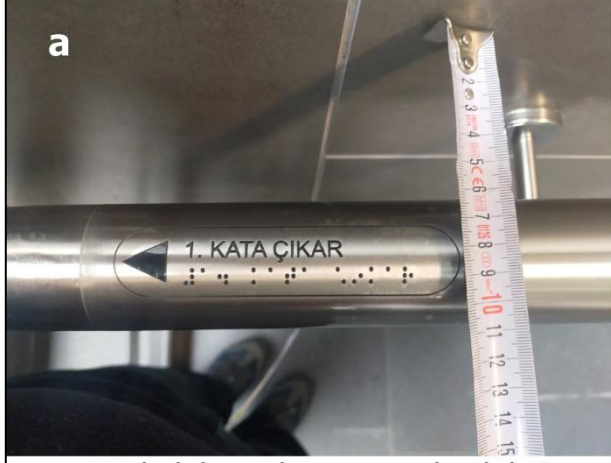
a- Korkuluk ve duvar arası boşluk 6 cm
