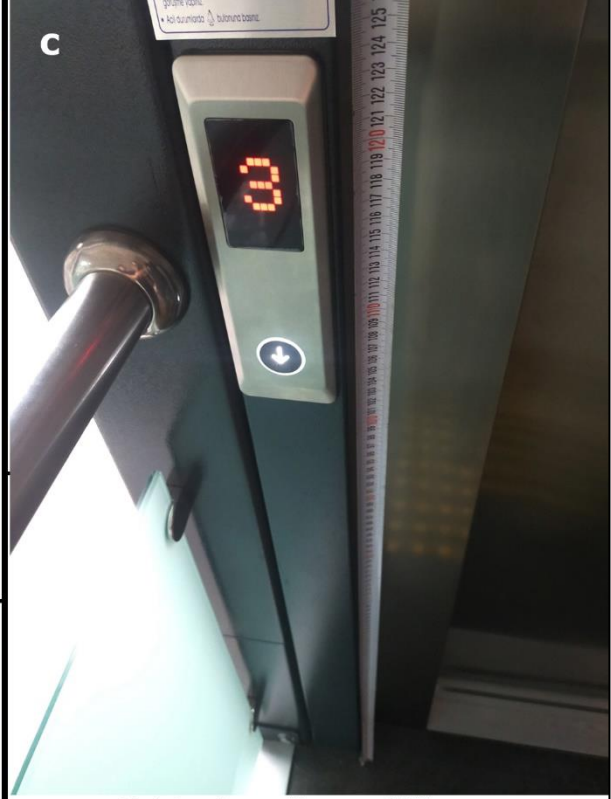
c- Kabin dış çağırma düğme yüksekliği 100 cm
