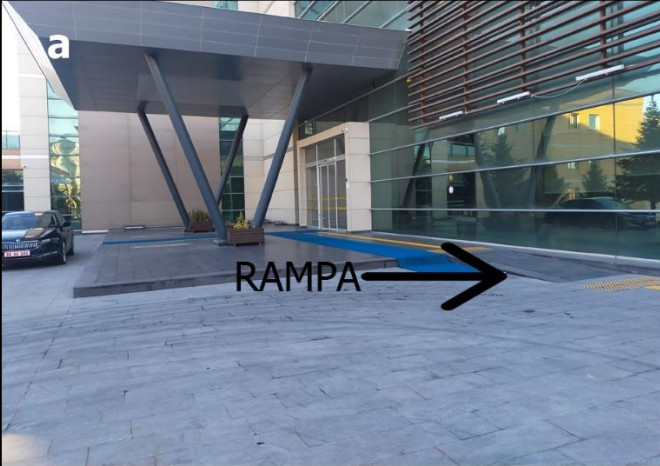
a- Bina Girişi ve Rampa
