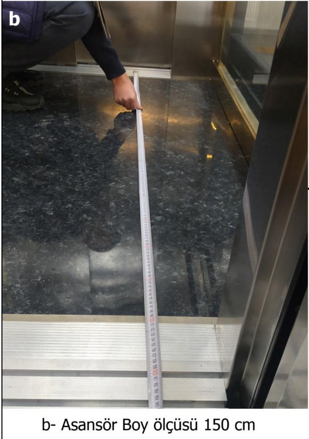
Fotoğraf 4.4. Tüm katlara hizmet veren asansörler, kabin içi ölçüleri, kapı ölçüsü ve tutunma barı yüksekliği
