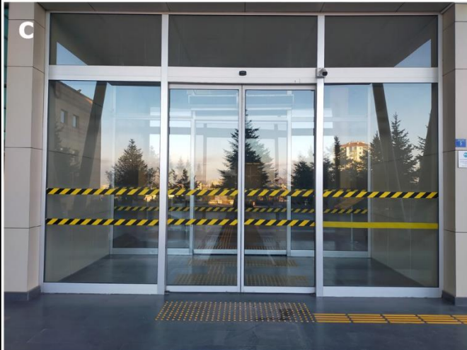
c- Bina Girişi Dış Görünüş
