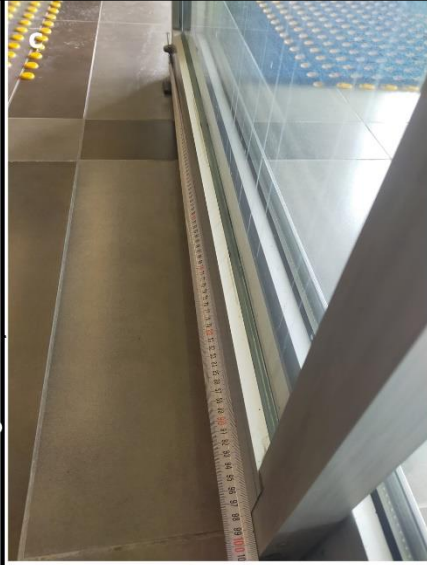
c- Bina Giriş Kapısı tek kanat Ölçüsü 100 cm
