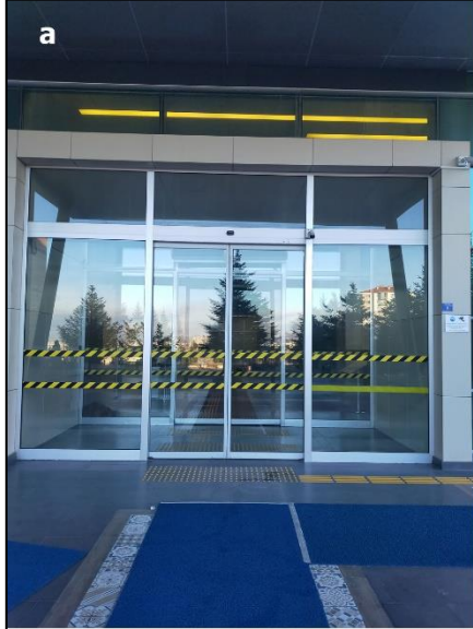
a- Bina Giriş Kapısı
