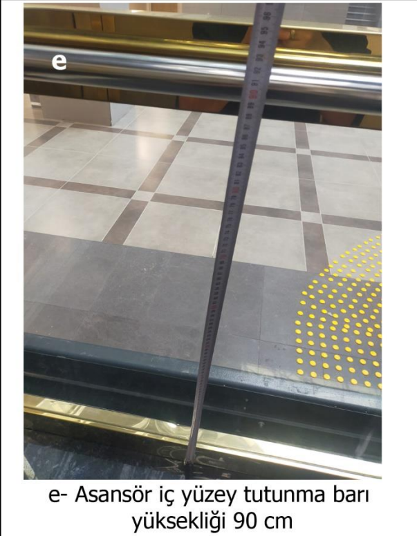
Fotoğraf 4.4. Tüm katlara hizmet veren asansörler, kabin içi ölçüleri, kapı ölçüsü ve tutunma barı yüksekliği
