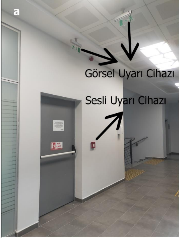
a- Acil Çıkış Kapısı, Görsel Yönlendirme ve Sesli Uyarı Cihazı
