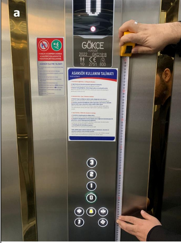
a- Asansör kontrol paneli yüksekliği 90-110 cm
