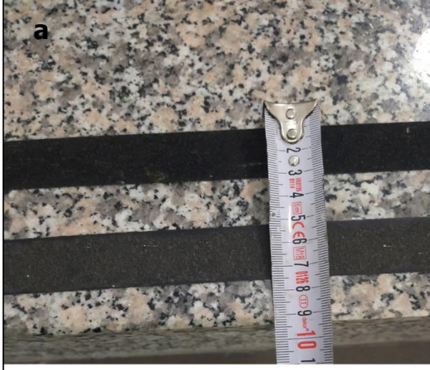
a- Merdiven Basamağı 2,5 cm lik iki adet kaymaz bant uygulaması
