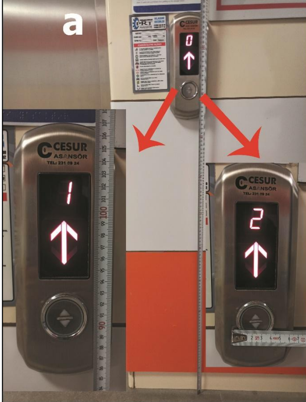
a-Asansör Çağırma Düğmesi Yerden 90 cm yükseklikte olup 3 cm boyutundadır.
