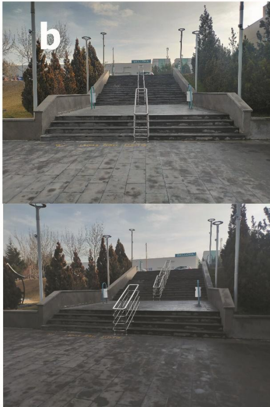
b- Dış Merdiven korkuluk uygulaması
