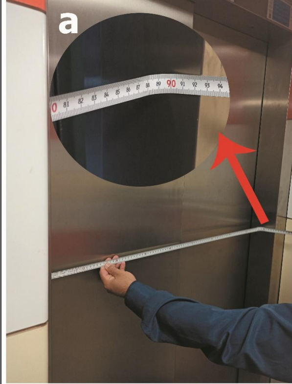
a-Asansör kapı ölçüsü 90 cm boyutundadır.
