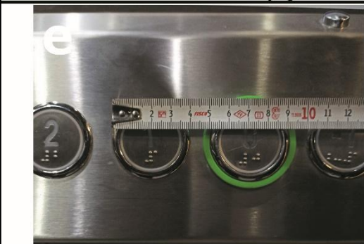
e- Asansör Kat Düğme Genişliği 3 cm
