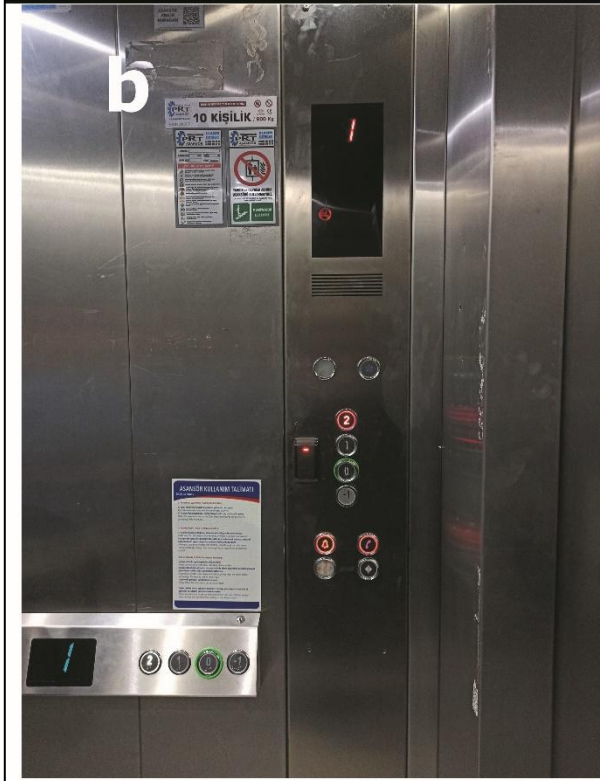
b- Kat işaret düğmeleri boyut bakımından uygundur ve istenen yüksekliktedir
