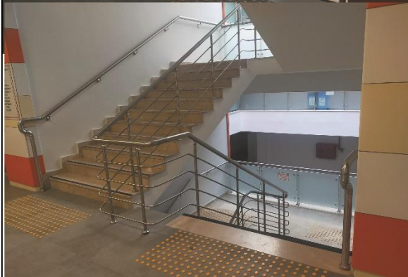
Fotoğraf 5.4. Merdiven başlangıcı ve bitişinden 30 cm ileride başlayan korkuluklar ve tüm basamaklar boyunca devam eden korkuluklar, Korkuluk ile duvar arası boşluk ve korkuluk tutunma barı çapı
