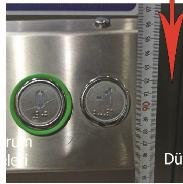
d- Asansör Kontrol Paneli Yüksekliği 90 cm
